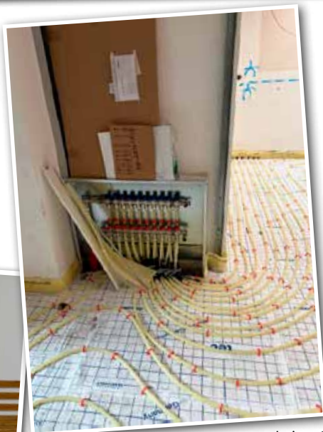
Verlegung und Aufbau der Fußbodenheizung
