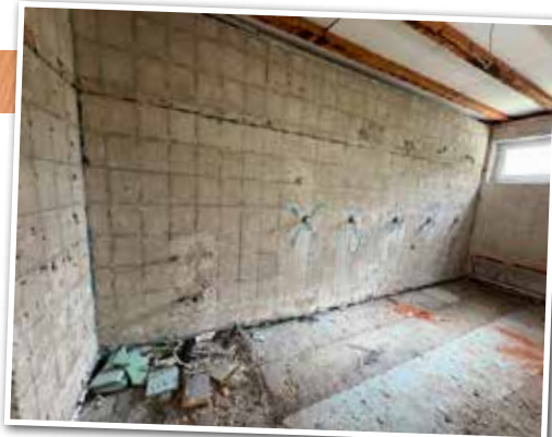
Entkernung des Gebäudes (Entfernung von Fliesen, Putz, Fenstern, Estrich etc.)
