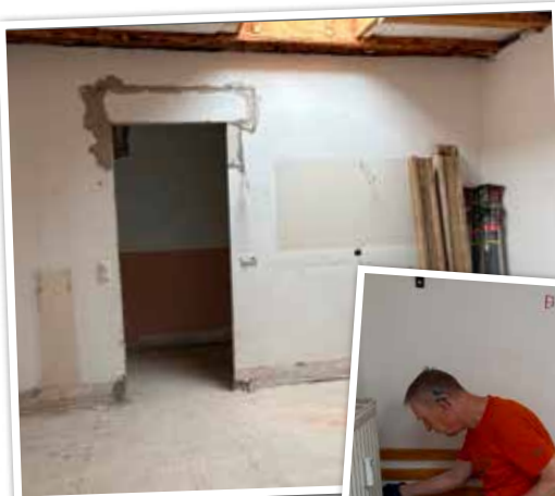
Abbauen/Ausräumen der Inneneinrichtung
